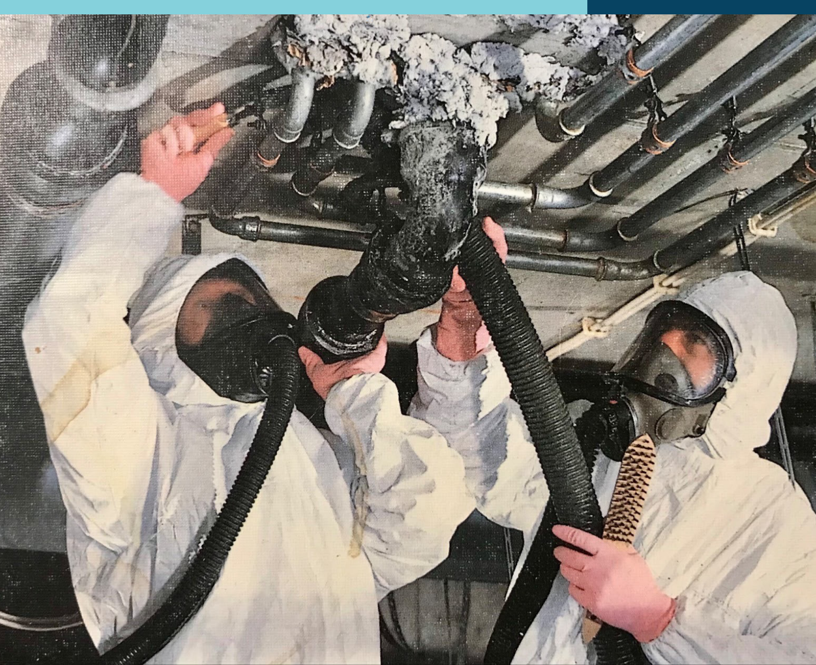
Fig.1: Asbestsanierung aus G:Albracht/O. Schwertfeger in "Herausforderung Asbest", Wiesbaden 1991
